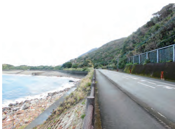
構造物が生物の移動を阻害
